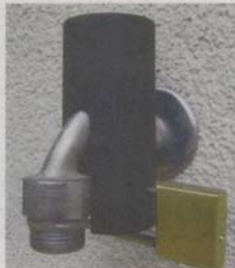
Einfache Sicherung des Außenwasserhahns ohne Aufwand Foto: Nitsche
